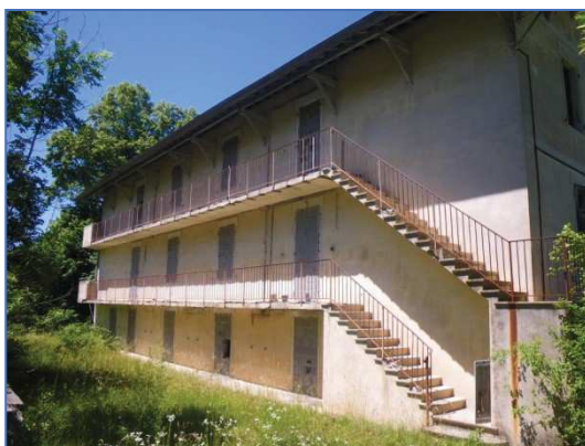
La Maison Rouge (bâtiment n°20), accès fermés par des parpaings
