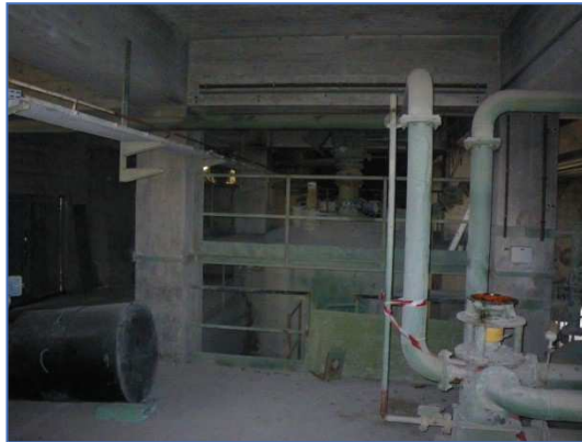
Intérieur du bâtiment n°6 désaffecté
