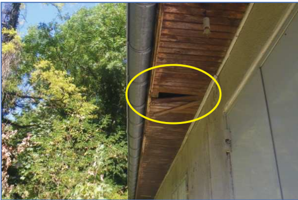
Maison n°22, accès aux combles visibles
