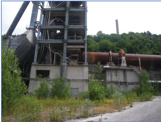
Bâtiment n°6 désaffecté de l'ancienne Cimenterie
